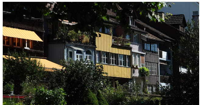
Wohnen in der Altstadt: vorne zur Hauptgasse und hinten zur Aare (Aarburg)
