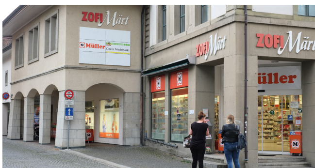
Der Zofi-Markt hat mit der Müller-Drogerie neue Nutzung mit Magnetwirkung erhalten (Zofingen)
